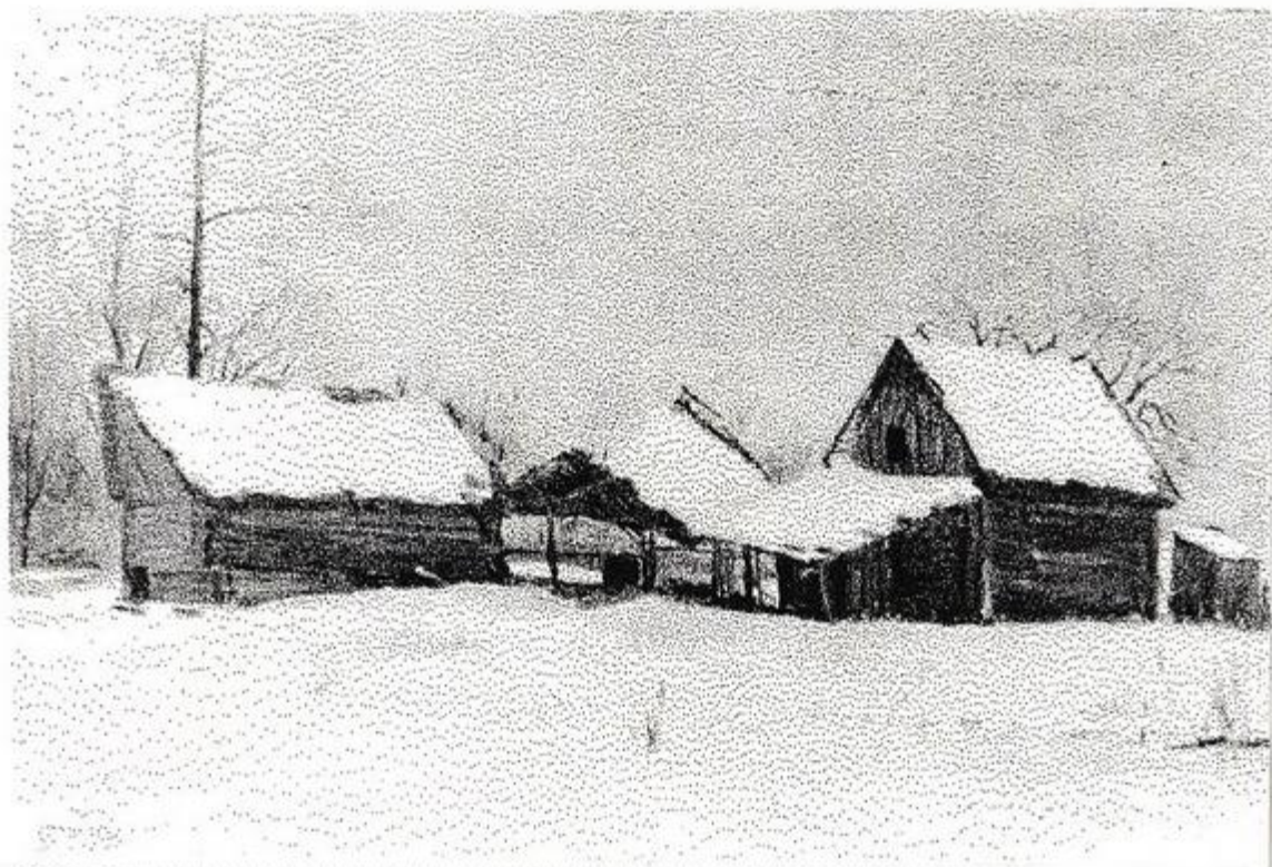
СНЕГ. ПОРУШЕННОЕ ПОДВОРЬЕ
